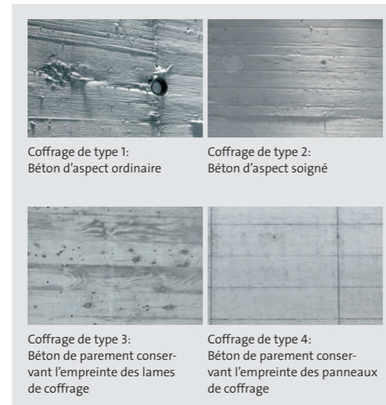
Fig. 17 Types de coffrages selon norme SIA 118/262 [1].
