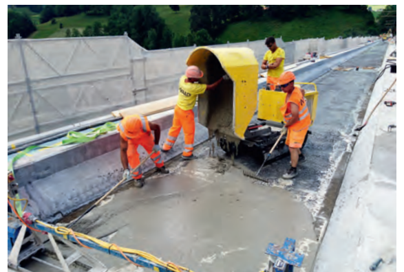
Pose d'une couche de Ductal® sur le fond de l'auge.
