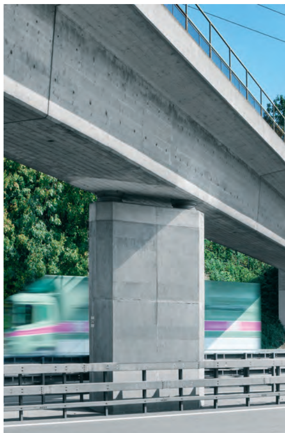
Gaine d'un pilier de pont avec des éléments en BFUP de 40 mm d'épaisseur pour une protection contre les attaques de chlorures (réalisation : 2010).
