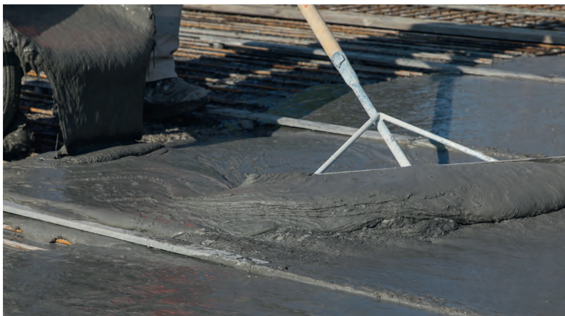
La consistance de Ductal® est mielleuse et fortement visqueuse.
