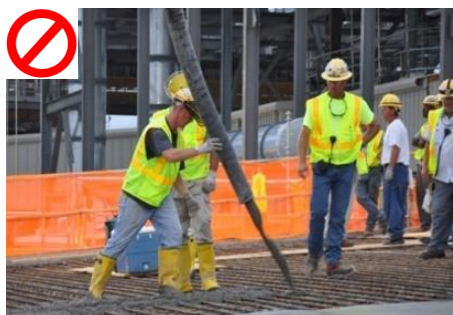
Gefahrenzone des Endschlauchs
